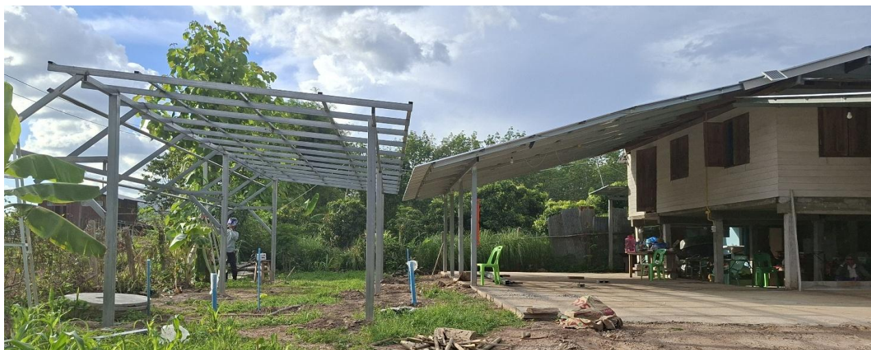
Construction de la cuisine
